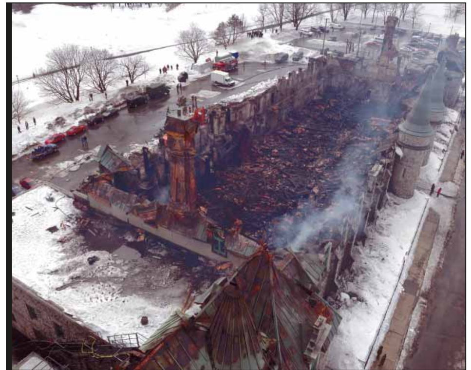
Les ruines fumantes du Manège militaire témoignent de la violence de l'incendie.
