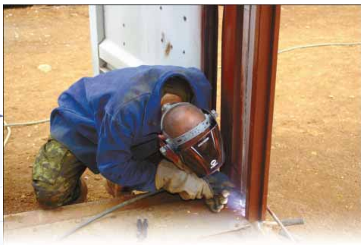
LS Robert Boucher, CFB Fleet School, Esquimalt, soude une poutre à l'intérieur d'un des conteneurs maritimes au camp Moneague.
