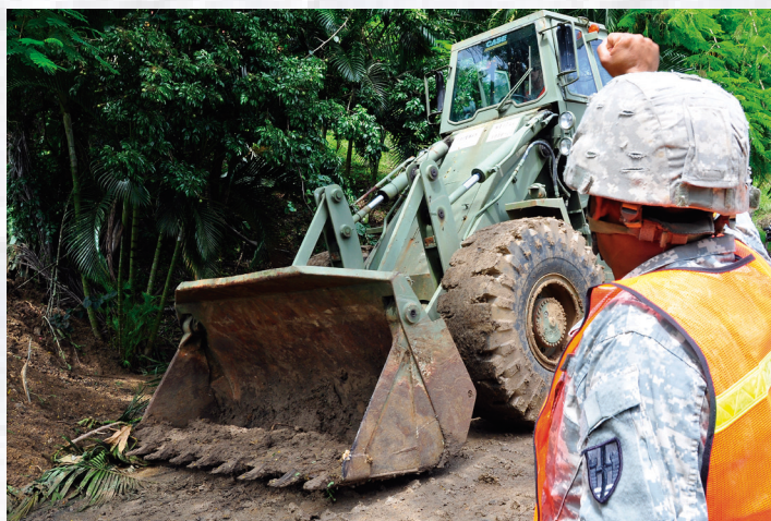
Ingenieros de la GNPR estuvieron haciendo trabajos de rehabilitación de carreteras y labores de remoción de tierra y escombros tras derrumbes en el pueblo de Cayey que fueron causados por el paso de la Tormenta Tropical Irene el pasado agosto. (Foto por Sgto. de Estado Joseph Rivera Rebolledo, 113th MPAD)
