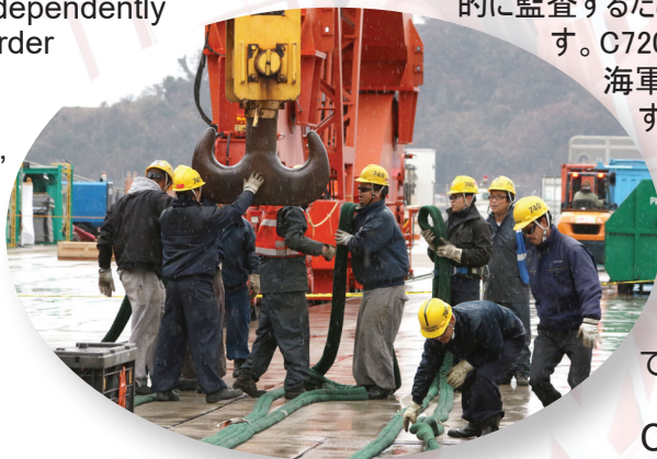
(Jan. 8, 2018) C740 members prepare slings for a mobile crane lift onto USS Ronald Reagan (CVN 76) during Navy Crane Center’s annual evaluation. (2018年1月8日)C740のメンバーが海軍クレーンセンターによる年間評価の最中にUSSロナルド・レーガン(CVN 76)に移動式クレーンを吊り上げるためのスリングを用意しています。
