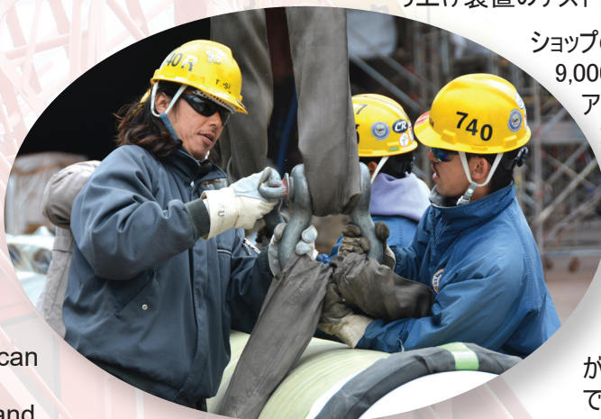
(March 3, 2017) C740 shop workers prepare a lifter to raise a shaft for fitting tests. (2017年3月3日)C740の作業員がフィッティングテストのためにシャフトを吊り上げるためのリフターを用意しています。
